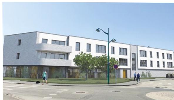
> Boulevards Pascal et des Poètes (Petit-Fort-Philippe), suite à la déconstruction des anciens bâtiments de Partenord – 32 logements .
