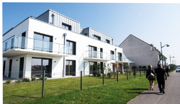
> La Flotille (Petit-Fort-Philippe), avec Demathieu Bard Immobilier – 35 logements .
