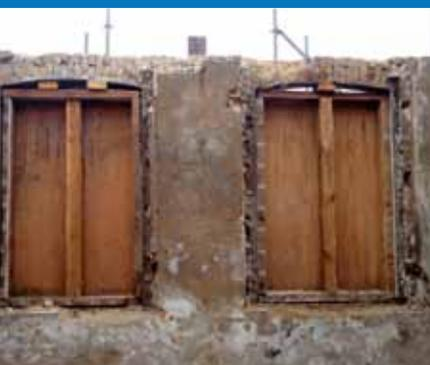
↑ Maçonneries mises à nu après dépose des fenêtres et bois de structure
