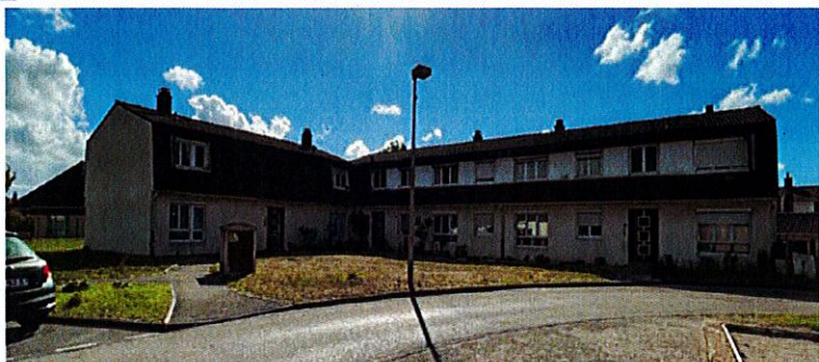
Façade avant travaux
