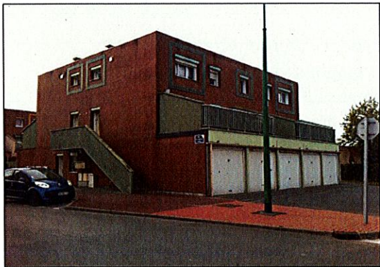
Façade avant travaux
