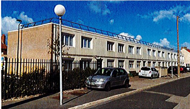
Façade avant travaux
